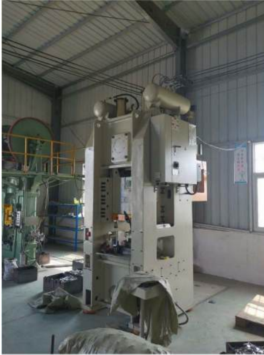
项目车间现状
