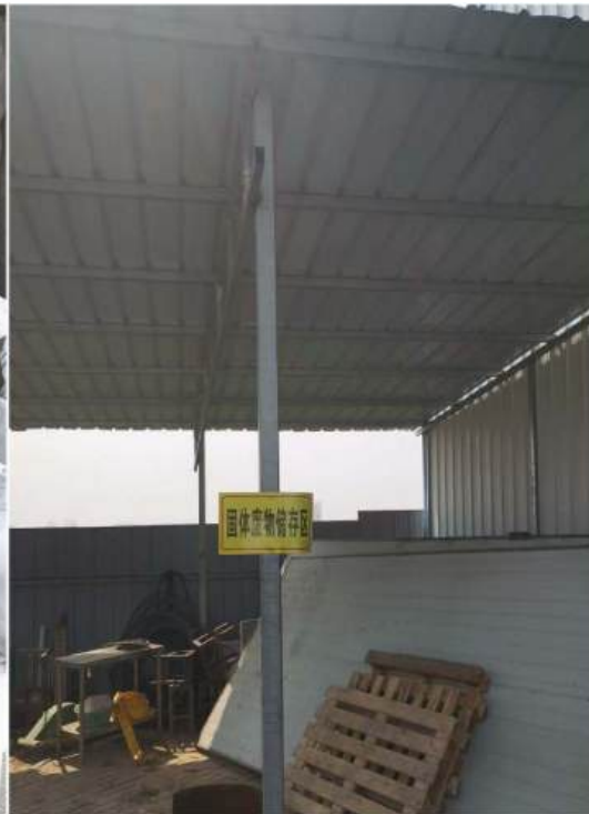
项目一般固废暂存间
