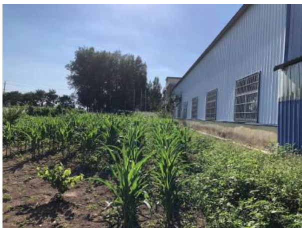
项目南侧现状
